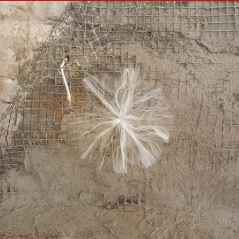
Alkalibeständiger Glasfaserverbinder, mit vorgeformtem starrem Mittelsegment und doppeltem losen Ende, abnehmbar. Geeignet für die strukturelle Verstärkung von Ziegel-, Tuff- und Steinmauerwerk, Bögen und Gewölben in Kombination mit ARMAGLASS STRUCTURA Glasfasergeweben und Mörteln wie Unisan, Intosana und der REPAR-Familie. Es dient als Durchgangsverbindung zur Verbindung der beiden Seiten eines Strukturputzes ("Structural Sandwich"-Technik).
