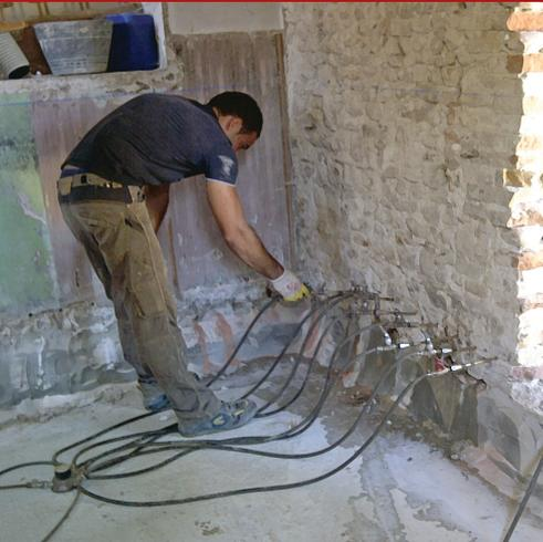
Lösung aus speziellen modifizierten Siliconharzen, in Wasser dispergiert, hydrophil während der Anwendungsphase, hydrophob und wasserabweisend nach Reaktion mit atmosphärischem Kohlendioxid.
