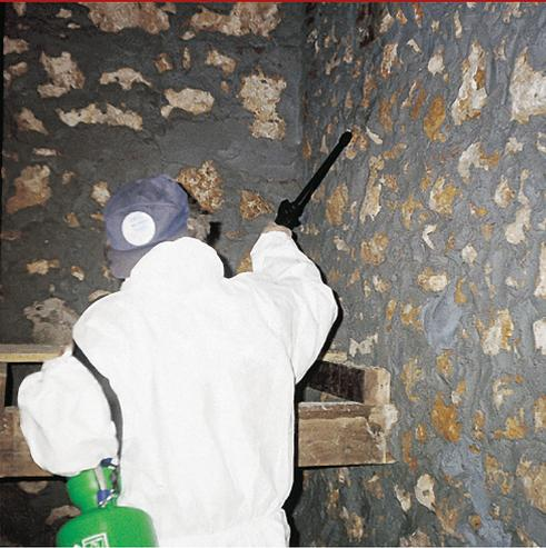
Spezielle ausgewogene Lösung aus Kieselsäureester, Silane und Siloxane, in Lösungsmittel, gekennzeichnet durch hohe Penetrations-Kapazität in Siliziumhalterungen und der doppelten Wirkung der Konsolidierung und Wasserabweisung, für die Schutzbehandlung, Festigung und Hydrophobisierung von mineralischen und steinigen Trägern. Verursacht keine Farbänderungen oder Änderungen der Atmungsaktivität.
