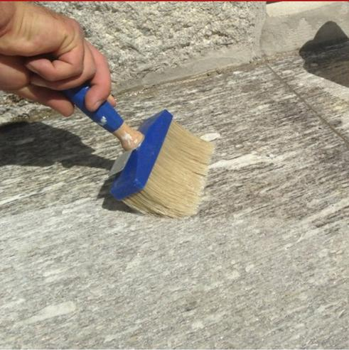
Consilex Idroplus ist ein konzentriertes wasserabweisendes Silikon zur Hydrophobierung, Behandlung von Salzausblühungen und Verfestigung von absorbierenden mineralischen, auch alkalischen Baustoffen. VOC = 0
