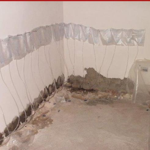
Einkomponentensystem konzentriert (60 - 65%) auf modifizierter Silanbasis zur Herstellung, nur durch Zugabe von Wasser, einer hydrophoben Mikroemulsionen für Injektionen in Mauerwerke, Erstellung von chemischen Barrieren, durch langsame Diffusion, gegen die Verminderung von aufsteigender Feuchtigkeit in Kapillarporen von Ziegel- und Steinmauerwerken, Tuff- oder Mischmauerwerken, mit variierender Dicke.
