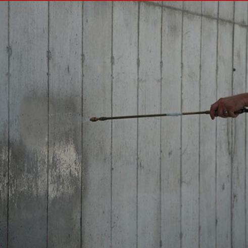
Consilex No-Rust ist ein leistungsfähiger Korrosionsinhibitor, nicht-toxisch, anzuwenden auf Oberflächen von Betonstrukturen, welcher dank der besonderen chemischen Natur, in das Innere des Konglomerats wandert und seine speziellen Substanzen auf das interne Bewehrungsseisen deponiert, die deren Integrität im Laufe der Zeit bewahrt und die Oxidationserscheinungen hemmt.
