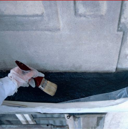
Transparente eindringende Konsolidierung, für Naturstein, dekorative Steinelemente, Mineralputze etc.. Zusammengesetzt aus Kieselsäure-Ethylestern in Lösungsmittel, aushärtend durch Reaktion mit Luftfeuchtigkeit. Anwendung durch Besprühen mit Niederdruckpumpe, bis zur Ablehnung der behandelten Oberflächen.
