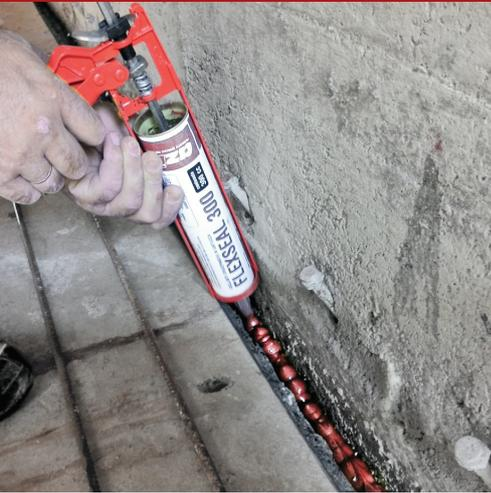
Quellfähiger Dichtstoff aus thixotropischer Paste, prekonfektioniert in extrudierbarer Kartusche für gewöhnliche Kartuschenpresse, als Fugenband in den komplexesten und schwierigsten Situationen der Abdichtung von unterirdischen Räumen, zu verwenden. Hält unverändert in der Zeit seine elastischen und hermetischen Eigenschaften bei. In vollständig trockenem Zustand schrumpft Flexseal 300 auf seine ursprüngliche Größe und dehnt sich bei Kontakt mit Wasser wieder aus.
