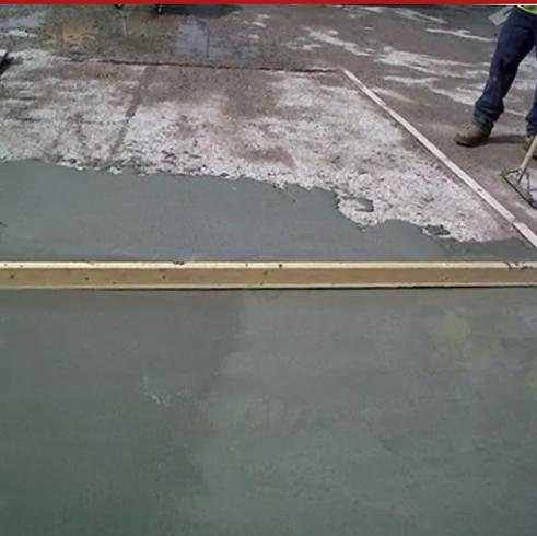
Floor Level SFR ist ein selbstnivellierender zementärer Mörtel aus modifiziertem Polymer, faserverstärkt mit Readymesh MR-060-Fasern, mit beschleunigter Abbindung und schneller Aushärtung, der für flächige Ausgleichungen mit einer Dicke von 3 mm bis 25 mm vor dem Verlegen von Bodenbelägen geeignet ist. Dadurch ist es für jede Art von Belag geeignet.
