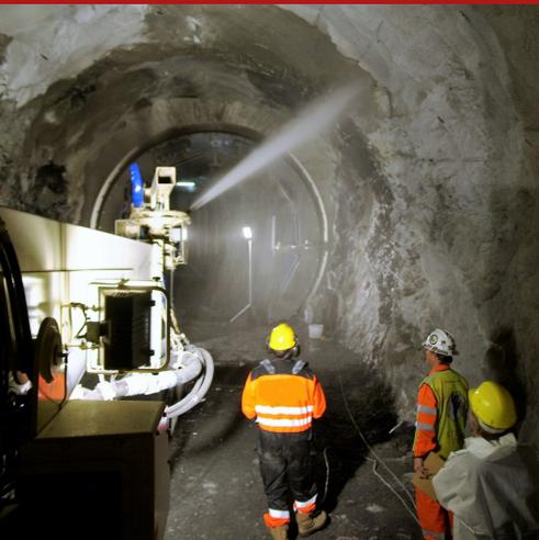
Lösung aus organischen Reagenzien (Natriumsilikat), die für die Beschleunigung der Abbindung von Einpressmörtel und Spritzbeton, Konsolidierung von Felsen im Freien und / oder in Tunnel, Bau von selbsterhaltenden Beschichtung und Wasserabdichtung für Tunnel, Kanäle, Gewölbe, Becken, unterirdischen Arbeiten, etc., zu verwenden mit spezieller Ausrüstung für hydrierte Mischungen (Mischungen, in denen das Silikat auf die Ausgangslanze des Spritzbetons gespritzt wird).
