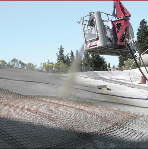
Mehrweckadditiv in faserverstärktem Pulver, zum Hinzufügen in eine geeignete Mischung aus Bindemittel und Zuschlagstoffen, für die Herstellung von Mörtel, Reparaturmörtel und Betonen, thixotrop, schwundkontrolliert, mit hoher mechanischer, chemischer und wasserabweisender Leistung.
