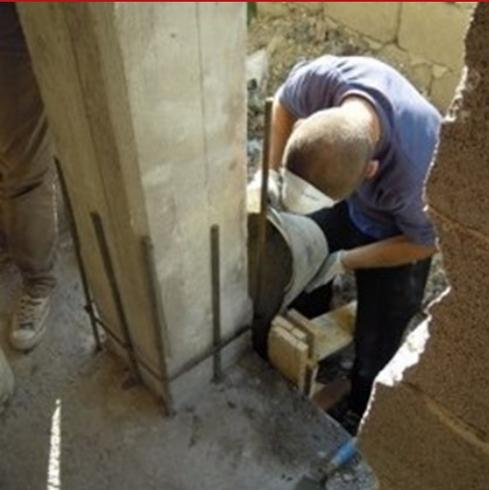
Grout 2 SFR ist ein sehr leistungsfähiger selbstnivellierender Gießmörtel, der mit Readymesh MM-150-Stahlfasern und Readymesh PM-060-Polypropylen-Mikrofasern verstärkt ist, mit hoher Druck- und Biegefestigkeit, guter Haftung auf Beton und Stahl, schrumpfkompensiert. Mit einer maximalen Aggregatgröße von 2 mm. Ideal für Restaurierungen, Verstärkungen, seismische Anpassungen, mit duktilen Eigenschaften, für Abschnitte mittlerer Dicke (3-10 cm), an Stahlbetonkonstruktionen und Mauerwerk.
