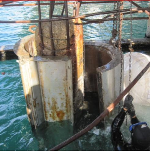
Zusammengesetzter Zementmörtel, gießbar, anti-auswaschung, schwundkontrolliert, in sehr flüssiger Konsistenz auf Basis von hochfestem Zement, superpuzzolanischen Füllstoffen (MICROSIL 90), polymere Modifizierungsmittel, anti-schwund-wirkstoffe, spezielle Zusatzstoffe, Mineralfasern aus Calciumsilikat und ausgewählten siliciumhaltige Aggregate.
