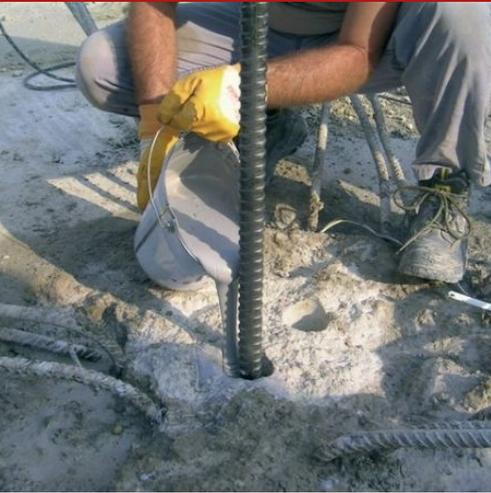
Schwindkompensierter, rieselfähiger, selbstverlaufender, superadhäsiver Zement-Mikromörtel, basierend auf hochfesten Zementen, superpuzzolanischen Füllstoffen, polymeren Stabilisatoren, Schwindkompensierern. Mit einer maximalen Aggregatgröße von 0,35 mm. Ideal für Konsolidierungs- und Bewehrungsinjektionen auf Beton, Mauerwerk und rissigen/beschädigten Gesteinen. Verankerung und Befestigungen von Stahlstangen, Stiften, Klammern usw. auf Beton, Mauerwerk und Stein.
