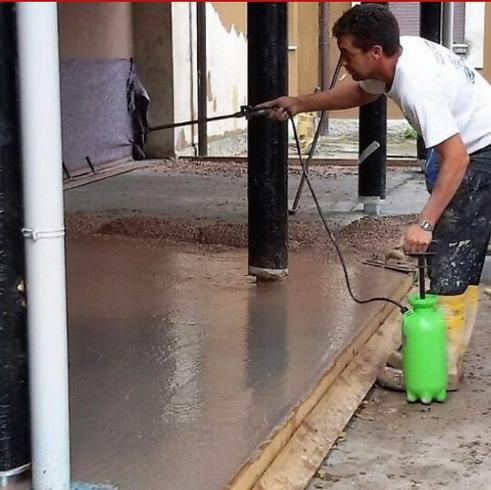
Reaktionshemmendes Mittel in wässriger Lösung, aufzutragen durch Niederdruck - Airless-Pumpe, auf frischen Betonflächen, um durch das Waschen mit Wasser, die Entfernung einer kortikalen Schicht von einigen Millimetern zu ermöglichen und daher die inerten Bestandteile des Zementkonglomerats freizulegen. Speziell für die Realisierung von Bodenbelägen mit landschaftlichem / umweltbedingtem Wert, mit der Technik des "gewaschenen Kies".
