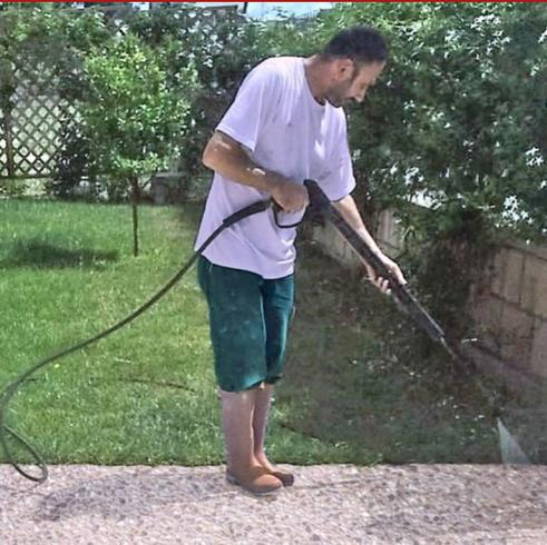
Wasser- und ölabweisendes, farbloses, nicht filmbildende Imprägnierung auf Basis einer Nanodispersion mit Siliciumverbindungen. Zum Schutz von gewaschene Kiesböden vor Witterungseinflüssen, Frost-Tau-Wechsel und extremen Wetterbedingungen. Ohne Einfluss auf Oberflächenfarbe, ursprüngliches Aussehen und Atmungsaktivität. Auch als Fleckenschutz während des Waschvorgangs der zu deaktivierenden Oberfläche auf den Artefakten um den architektonischen Bodenbelag zu verwenden.
