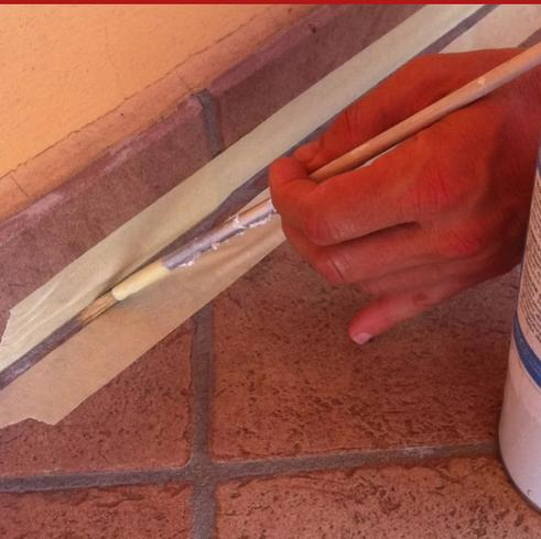
Polyurethan-Haftprimer zur Vorbereitung von Fugen in Betonflächen, Mauerwerken, usw. für die darauf folgende Füllung mit Dichtungsmittel aus Polyurethan (Protech Flex oder PROTECH SIGILFLEX MONO) oder Epoxy-Polyurethan (EG 91).
