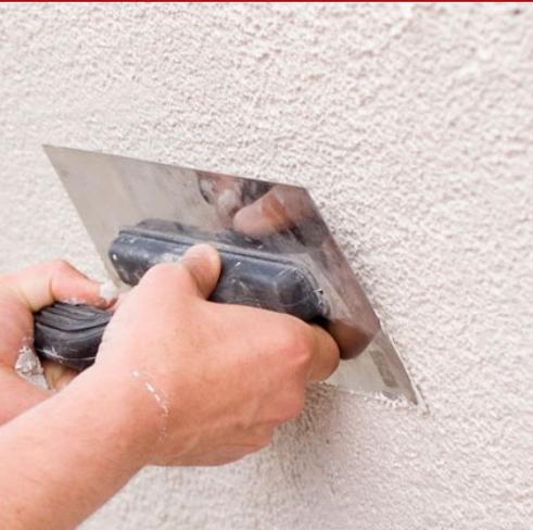
Nanotechnologischer Wandspachtel für den Innen- und Außenbereich, desinfizierendes und wärmedämmendes Anti-Kondensations-Elastomer, formuliert mit 3M Glass Bubbles, reflektierend auf Basis von Siloxanharzen in Emulsion mit hoher Wasserdampfdurchlässigkeit, mit einem normalputzähnlichen Erscheinungsbild.
