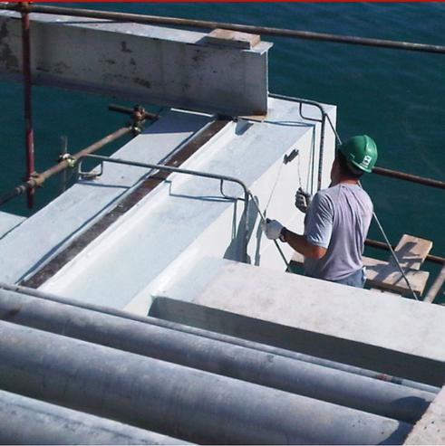
Pigmentierte Schutz- und Dekorfarbe, auf Basis von Acrylelastomeren in Emulsion, thermoplastischen Fluorpolymeren (Teflon), füllenden Aggregaten und feinen Farboxiden. Ideal für einen abdichtenden, wasserabweisenden Anstrich von Artefakten und Bauten in Beton oder Mauerwerk, welches sich in schwierigen Umgebungen (Meer- und Bergambiente, Chemie- und Stahlindustrien, etc.) befinden.
