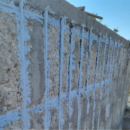
Einkomponentige Zementaufschlämmung in Pulverform, passivierend, hellblau, mit Wasser ergänzt, modifiziert mit superpuzzolanischen Füllstoffen, Flexibilisierung-Harze und Korrosionsschutz; Zur passivierenden Behandlung von oxidiertem Bewehrungsseisen, bei Instandsetzung von beschädigten Beton.
