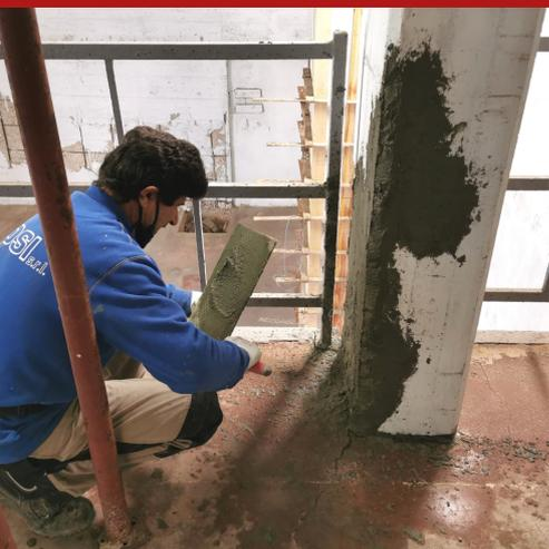
Struktureller Zementmörtel, thixotrop, plastisch, bestehend aus hochfesten Zementen, superpuzzolanischen Füllstoffen, Antischwundmittel, Weichmacher, Stabilisatoren, Rostschutzmittel, antiallergische Additive, ausgewählte Aggregate, Polypropylenfasern.
