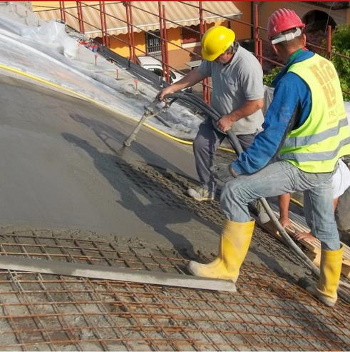
Struktureller, thixotroper Hochleistungs-Zementmörtel, faserverstärkt mit einer Mischung aus Metallmikrofasern (Länge = 6 mm, Durchmesser = 0,22 mm) und alkalibeständigen synthetischen Mikrofasern, zur Sanierung und Verdickung von Stahlbetonbauwerken und im Mauerwerk, auch in Umgebungen mit starker Belastung (Marine, Industrie, zyklisch trocken und nass).
