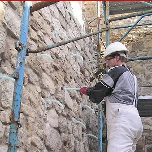
Präparat aus Pulver, gebrauchsfertig, auf der Basis von hydraulischem Kalk, für die Vorbereitung, mit nur Zugabe von Wasser, von Einpressmörtel für die Konsolidierung von Mauerwerken, injizierbar und gießbar, sehr hohe Leistung in Bezug auf Gleitfähigkeit, Resistenz und Stabilität, bei Eingriffen in ökologischen Gebäuden und Restaurierung von historischen Gebäuden und Denkmälern.
