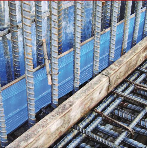
Das Fugenband SEAL PVC RG 250 ist ein wasserdichtes Profil in PVC mit einer Breite von 25 cm, mit hoher Elastizität (nicht hydroexpansiv) ausgestattet. Eingesetzt bei Arbeitsfugen in horizontalen (Fundamentplatten) oder vertikalen (Wände) Betoneinbauten, bei Betonkonstruktionen, in zentraler Position zur Arbeitsfuge.
