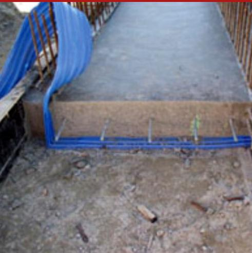
Das Fugenband SEAL PVC SF 250 BULB ist ein wasserdichtes Profil in PVC mit einer Breite von 25 cm, ausgestattet mit einer zentralen und mit hoher Elastizität (nicht hydroexpansiv). Eingesetzt bei dynamischen Arbeitsfugen in horizontalen Betoneinbauten (Fundamentplatten), in Betonkonstruktionen, die sich auf der Halterung unter der Armierung, in einer zentralen Position zum Betoneinbau befinden.
