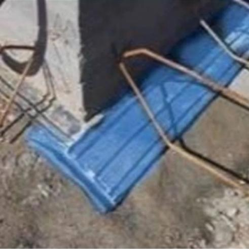
Das Fugenband SEAL PVC SF 250 ist ein wasserdichtes Profil in PVC mit einer Breite von 25 cm, mit hoher Elastizität (nicht hydroexpansiv) ausgestattet. Eingesetzt bei Arbeitsfugen in horizontalen Betoneinbauten (Fundamentplatten), in Betonkonstruktionen, angelehnt an der Halterung unter der Armierung.
