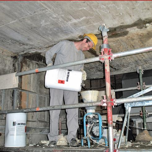
Spezifisches Reinigungsmittel für die benötigte Ausrüstung, während Injektionseingriffen, für die Hemmung von eindringendem Sickerwasser in Gebäuden. Öliges, abspülendes Reinigungsmittel, leicht toxisch, mit hoher Lösungsmittelkapazität für nicht ausgehärtete Polyurethane, zum reinigen und schmieren vom hydraulischen pumpenden Kreislauf des Inneren der Pumpen sowohl manuell als auch elektrisch. Es ersetzt Aceton, Methylenchlorid und andere üblicherweise verwendete Reinigungsmittel.
