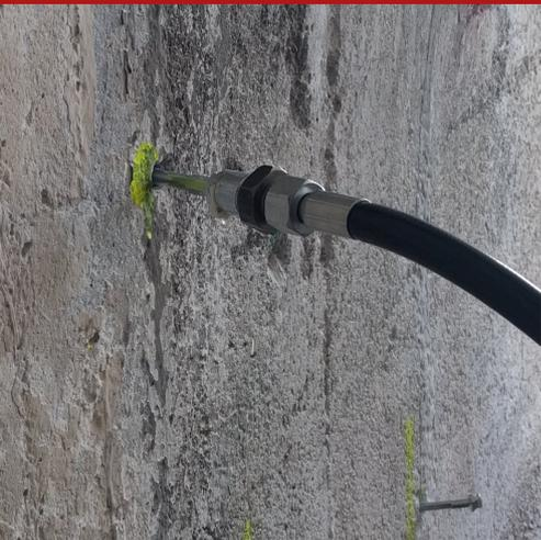
Verbindungselement zwischen den Flachkopfinjektoren und dem Pumprohr von manuellen oder elektrischen Pumpen, das zum Blockieren von Wassereintrüben durch Injektionen von wasserreaktiven Polyurethanharzen verwendet wird.
