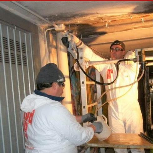
Dauerhaft flexibler, einkomponentiger Polyurethanharz, hydroexpansiv (erhöht sein ursprüngliches Volumen um etwa das 10 fache), lösemittelfrei, ideal zur Versiegelung mittels Injektion, von großen und kleinen Einsickerungen in Beton oder in Vollmauerwerk im Allgemeinen. Ideal zum verfüllen von kleinen Hohlräumen, Verbindungen und Diskontinuitäten, die Bewegungen ausgesetzt sind.
