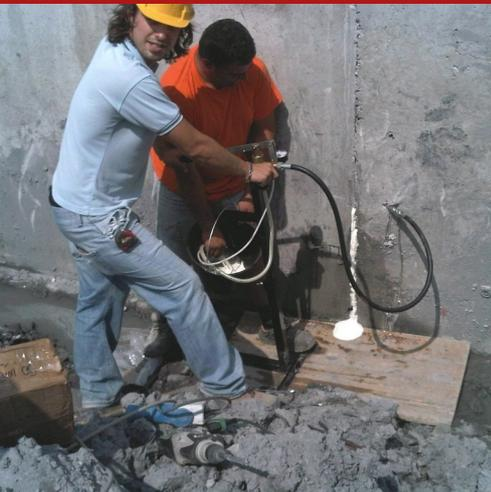
Manuelle Pumpe mit einem Kolben, selbstansaugend, mit einfachem Effekt, zur Injizierung von flüssigen Polyurethan- und Epoxidharzen. Der maximale erbringbare Pumpendruck beträgt 40 bar. Die Fließgeschwindigkeit beträgt 1 Liter in 55 Zyklen.
