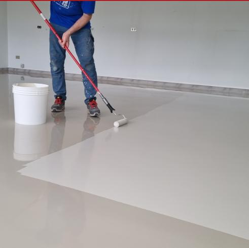
Zwei-Komponenten - Farblack auf Basis von Epoxid- und Aminoplastharzen in wässriger Dispersion. Ideal zur pigmentierten Beschichtung von Industrieböden und Betonsegmenten im Allgemeinen. Mit Syntech Pavicrom behandelte Oberflächen sind leicht zu reinigen und weisen eine hervorragende Beständigkeit gegen mechanischen Verschleiß sowie gegen Wasser, Laugen, Reinigungsmittel und Kohlenwasserstoff (Öl, Diesel, Benzin usw.) auf.
