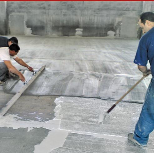
Zweikomponentiges transparentes Epoxysystem auf Basis von Epoxid- und Aminharze in wäßriger Dispersion, lösemittelfrei. Ideal zu Schutzbehandlungen, transparent, durch einen hohen Feststoffgehalt und Staubschutz auf Industrieböden aus Beton mit guter mechanischer und chemischer Beständigkeit, insbesondere im Bezug auf Kontakt mit Ölen und Lösungsmittel. Es eignet sich auch gut als Grundierung für Arbeitsfugen zwischen alten und neuen Betonböden.
