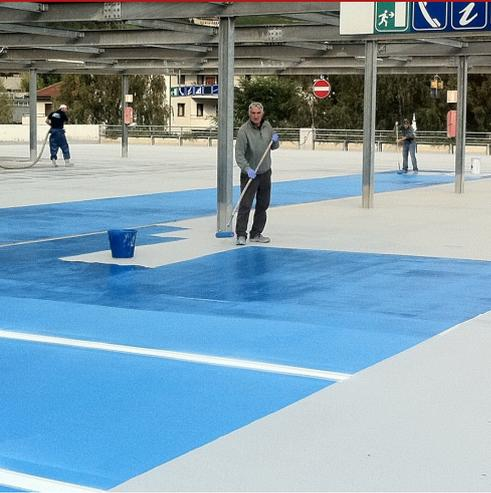
Schützende, pigmentierte, zweikomponentige Formulierung auf Basis von aliphatischen Polyurethanharze, ideal für wasserabdichtende Schutz- und ästhetische Beschichtung, ausgeführt mit SYNTECH POLIUREA SPRAY. Gekennzeichnet durch ein hohes Maß an Elastizität und Schutz, selbst bei Anwesenheit von aggressiven Atmosphären. Auf Anfrage erhältlich in den Farben der RAL-Farbpalette.
