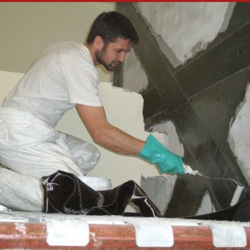
TECHNOKOMPOSIT ist das Akronym, dass speziell entworfene Systeme für die strukturelle Verstärkung und Konsolidierung von Gebäuden, Gegenstand von starkem Abbau, auch aufgrund von tellurischen Ereignissen, durch Verwendung der Technologie der Verbundsysteme (FRP - FRCM) auf Basis von Kohlenstofffasern, Basalt, Glas und Aramid, vorschlägt, entwirft und liefert.
